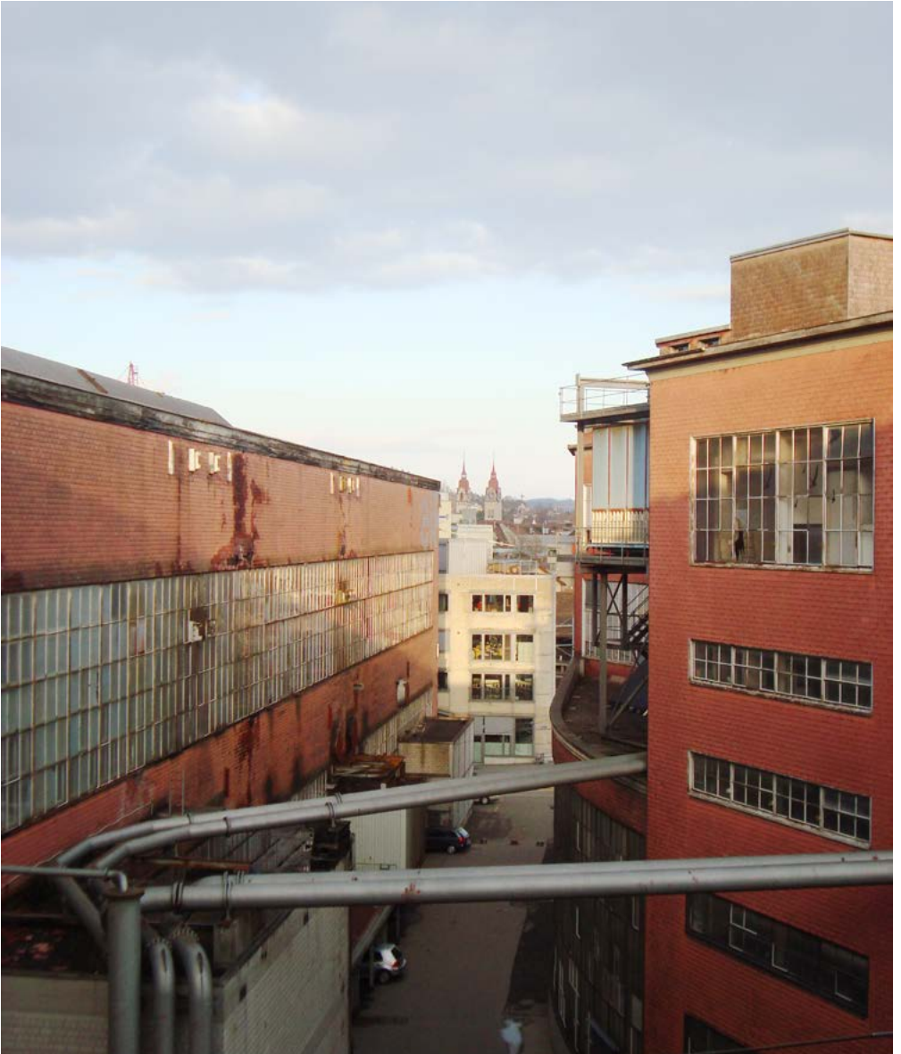
Die Hallen 11 und 87 bildeten ein städtebauliches Ensemble und harmonierten auch im Fabrikbetrieb. (Abb. 13)
