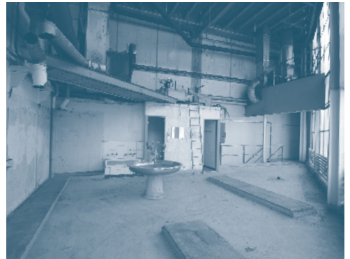
Nicht alle Zeugnisse der industriellen Vergangenheit konnten erhalten werden. (Abb. 28)
