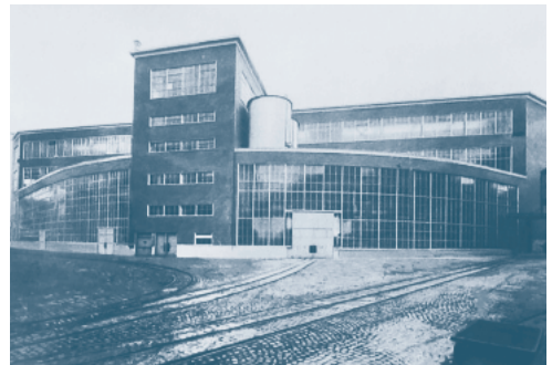
Mit seiner geschwungenen Fassade passte sich der «Rundbau» dem Verlauf der Werkgleise an. (Abb. 11)
