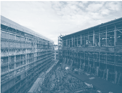
Dass die einst als Ensemble erstellten Hallen 87 und 11 zusammen umgebaut werden konnten, war ein Glücksfall. (Abb. 27)
